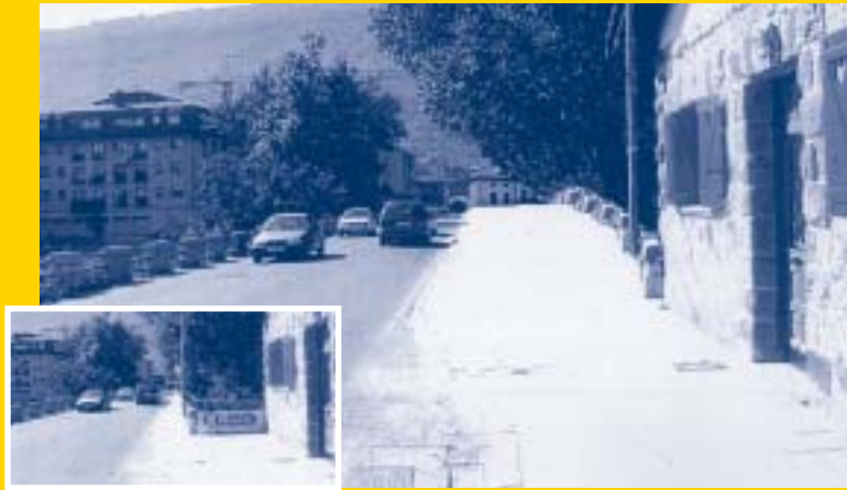
Izquierda, estado actual del puente sobre el río Burunda. En la fotografía superior se aprecia la propuesta de ampliación de la acera, con el fin de mejorar la comunicación entre Bentzelai-Lezalde-Dermao y casco urbano.
