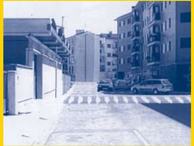
Paso sobre elevado en la entrada Escuela Zelandi.
